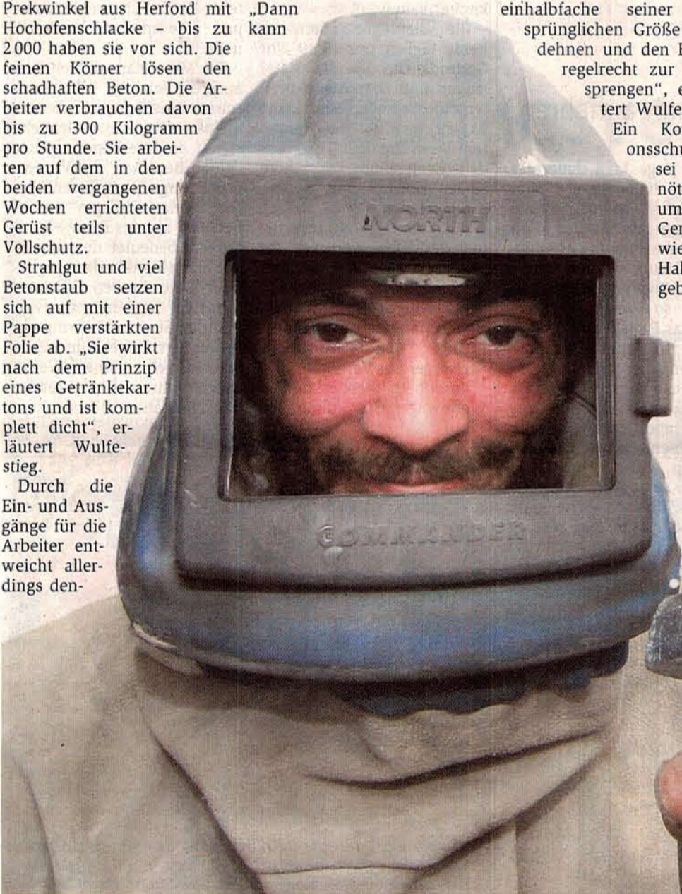
Marco Giovannetti begann gestern mit den Strahlarbeiten im Ringtunnel. Um den schadhaften Beton für die Sanierung vorzubereiten, strahlen er und seine Kollegen die Tunneldecke mit Hochofenschlacke. Bis zu 300 Kilogramm des feinen Granulats verarbeiten sie pro Stunde. ■ Foto: Hennes
